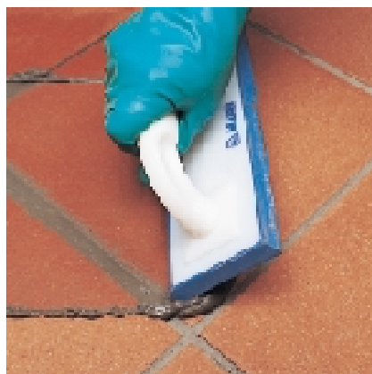
Nakładanie FUGOLASTIC na zniszczoną fugę
