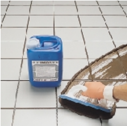
Fugowanie powierzchni o dużym natężeniu ruchu
