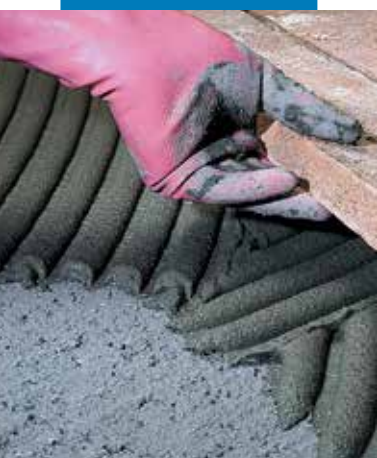
Układanie ręcznie wykonanej terakoty na nierównym podłożu
