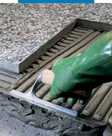
Montaż lastryko na zewnątrz
