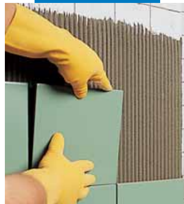
Układanie płytek na starej okładzinie ściennej
