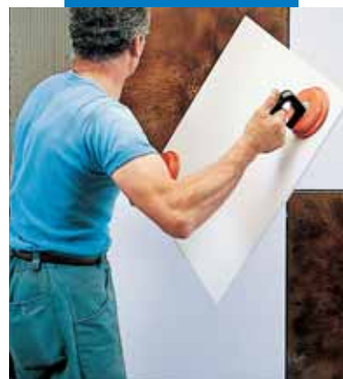
Montaż płyt KERAION na ścianie
