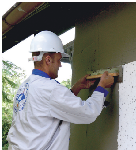
NAKŁADANIE KLEJU NA STYROPIAN
