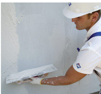
Nakładanie tynku pacą stalową
