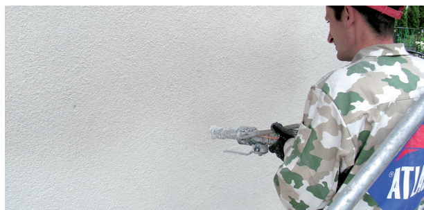
Nakładanie tynku metodą natryskową
