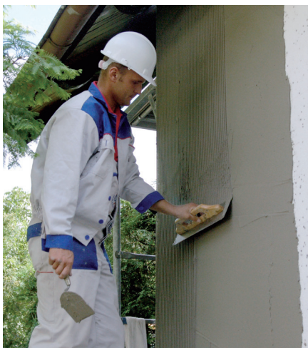
PROFILOWANIE KLEJU PACĄ ZĘBATĄ
